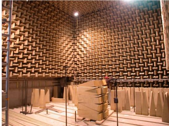
**Bild 36: Errichtung eines typischen reflexionsarmen Raumes mit Glasfaserkeilen**
